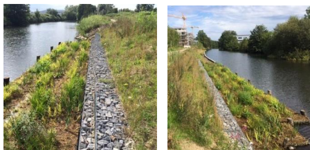
Plovoucí rákosový modul AquaGreen® na kanálu po osázení rostlinami a o několik měsíců později
