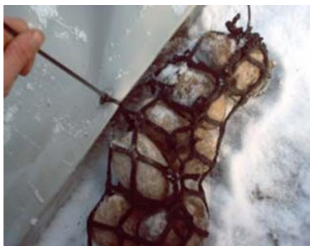
Detailní pohled na spodní konec norné zástěny, síť s kameny BesTec® jako závaží.
