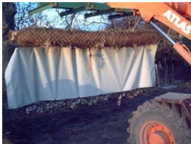
Pohled ze strany na osázené vegetační prvky včetně norné zástěny a sítě s kameny BesTec®, které zabraňují vynoření norné stěny.
