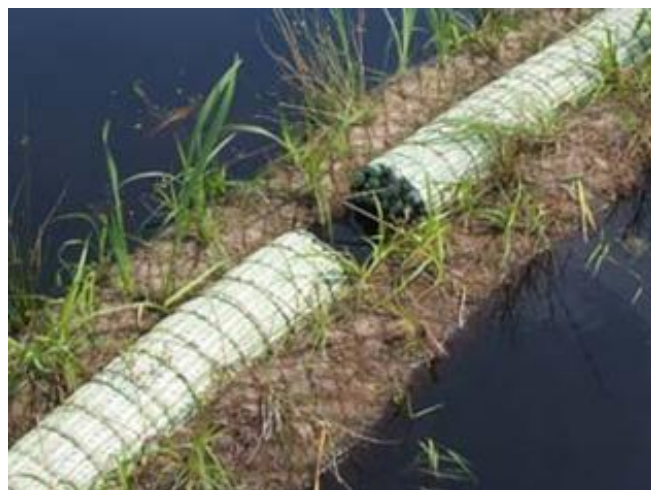
Detailní snímek hned po osázení a před pokrytím vztlakového tělesa RepoFloat® kokosovými rohožemi
